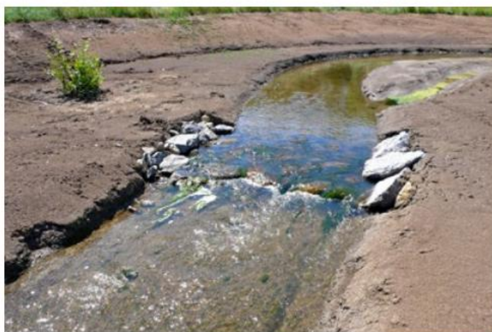
Obr. 4.14 Špatně provedený, ošizený dnový pas v revitalizačním korytě, který musel být následně předěláván. Pas je krátký, nedosahuje dolní uklidněné hladiny a přes jeho dolní okraj voda přepadá. Takový „stabilizační prvek“ by mohl v korytě paradoxně působit lokální hloubkovou destabilizaci. (Ostatně je vidět, že na i na korytu jako takovém se nevhodně šetřilo kamenivem. Bohatší nepravidelné pohozy dna hrubým šterkem by nepochybně přispěly jak ke stabilitě, tak k ekologické hodnotě nového koryta. Ne všude je odolné jílové dno jako v tomto případě a šetření na kamenivu se může vymstít.)
